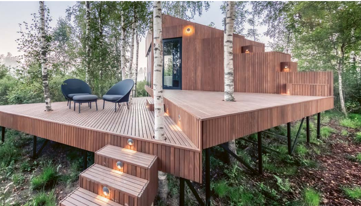
Bild: Thermo-Esche, Thermory, Architekt: Mari Hunt, b2IO Architekten, Projekt: Maidla Nature Resort, Estland, Foto: Elvo Jakobson
